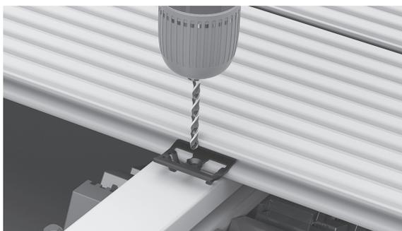
Clip mit Anschlag anlegen und mit 3 mm Bohrer vorbohren.
