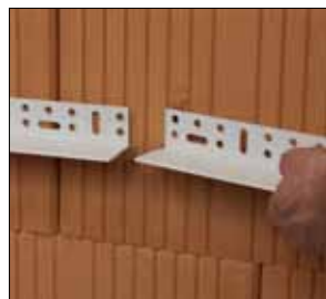
Winkelschiene anbringen
