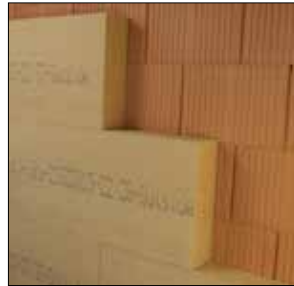
Verlegung kleinformatiger stumpfer Platten
