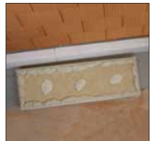
Dämmplatte ankleben auf unebenem Untergrund im Punkt-Wulst-Verfahren
