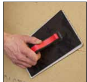
Plattenversätze beischleifen
