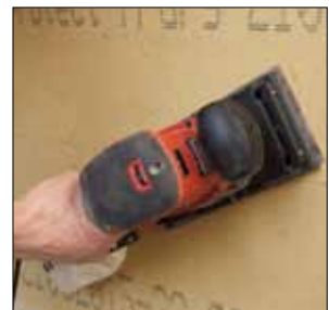
Plattenversätze beischleifen
