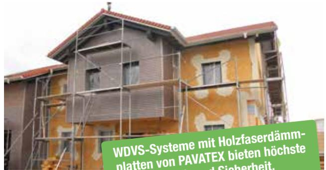
**WDVS-Systeme mit Holzfaserdämmplatten von PAVATEX bieten höchste Qualität und Sicherheit. Lebensdauer lt. Untersuchungen des Fraunhofer Instituts ≥ 50 Jahren**
