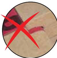
**So nicht:** Das Einlegen einer PAVATEX Abdeckbahn ADB schlaufenförmig in die Nut & Feder sollte vermieden werden. Eine saubere Verlegung der Unterdeckplatte kann bei dieser Anwendung nicht gewährleistet werden, zudem ist ein Wassereintritt durch Kapillarwirkung nicht gänzlich auszuschliessen.
