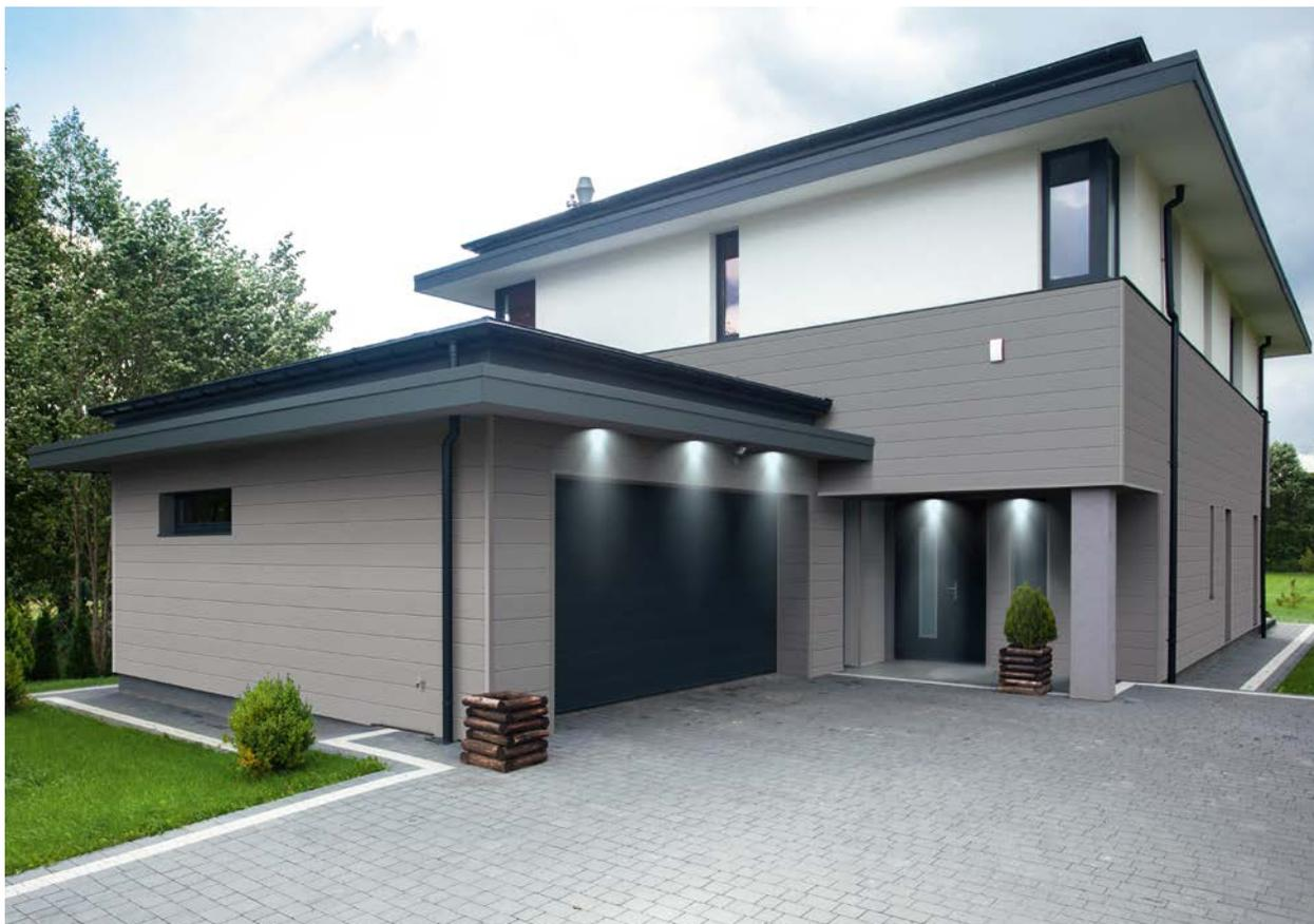
HardiePlank® VL Fassadenplatten horizontal installiert – Farbe: Nebelgrau
