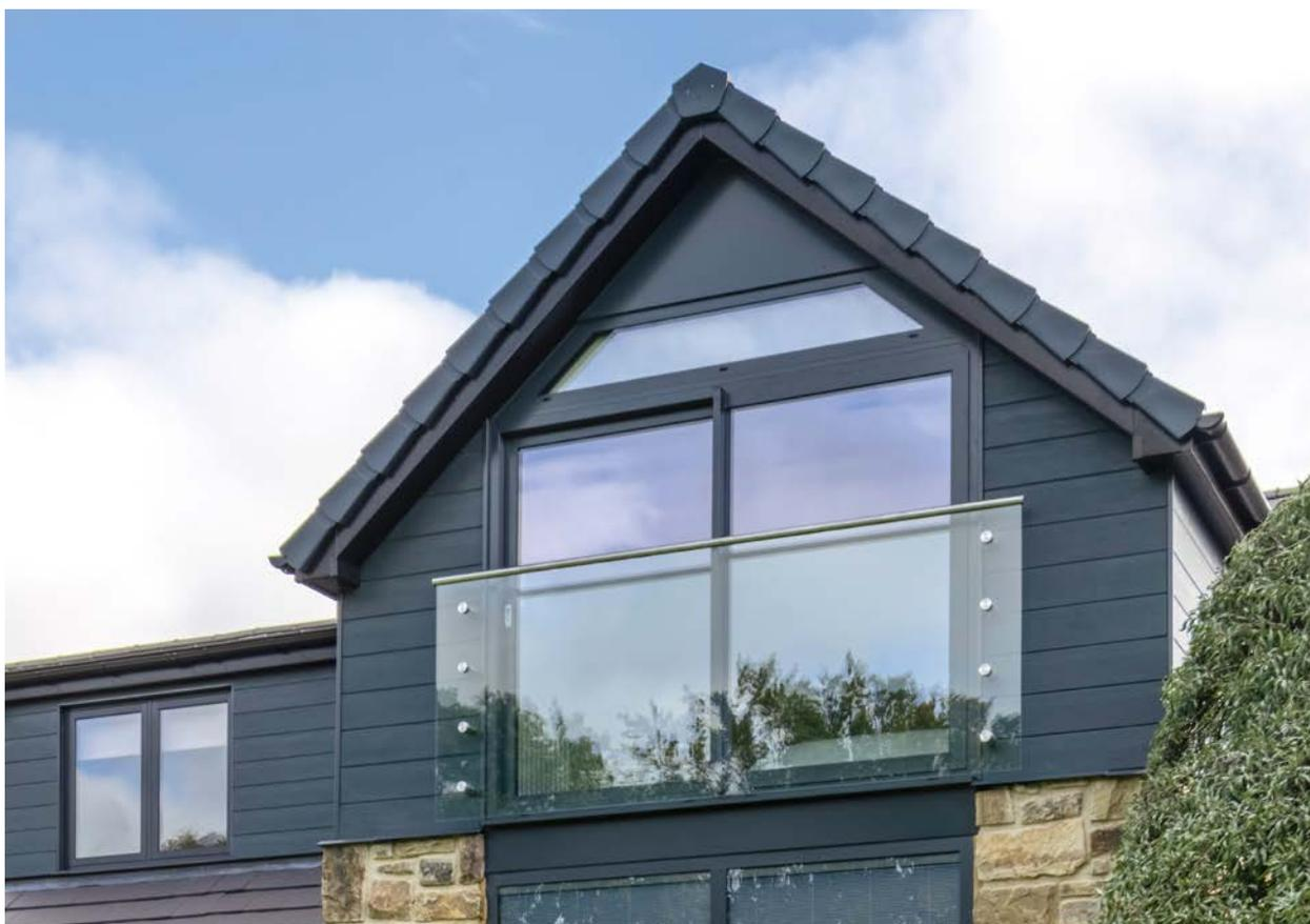
HardiePlank® VL Fassadenplatten horizontal installiert – Farbe: Anthrazitgrau
