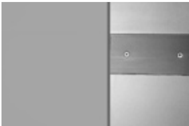
Lineare Befestigung an FPO Verbundblech
